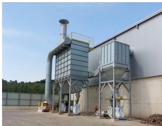
Foto 4: Foco F-3 (Filtro de Mangas en fachada sudeste de Nave de Separación de Metales)
